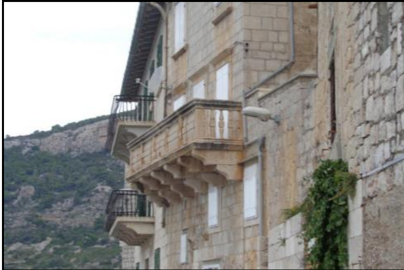
Slika 2.1-4. Postojeća javna rasvjeta
