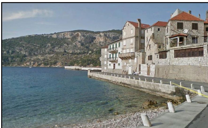
Slika 1.3-2. Parapetni zid - stanje ožujak 2012.
