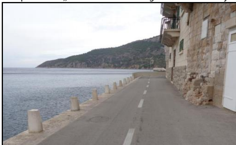
Slika 2.1-3. Postojeće kamene i betonske kolone na trasi obalnog zida
