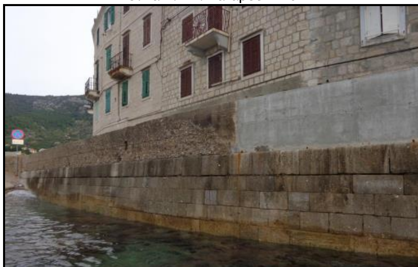
Slika 2.1-2. Parapetni zid - „stari“ dio i dio novoizgrađen nakon rušenja 2015. godine
